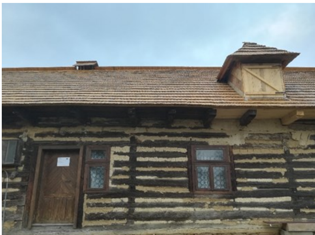
Foto č. 10 Ľudový dom (NKP) po výmene strešnej konštrukcie a zosilnenie statiky objektu
