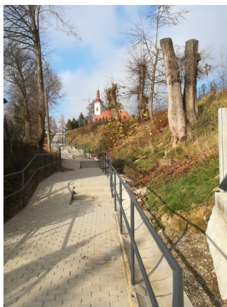
Foto č. 9 Novovybudovaný prístupový chodník ku kostolu
