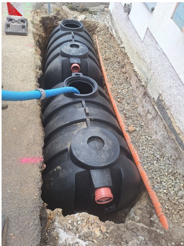
Odkanalizovanie budovy kultúrneho domu – osadenie žump 2 x 3000 l – hodnota 9.696,00 €
