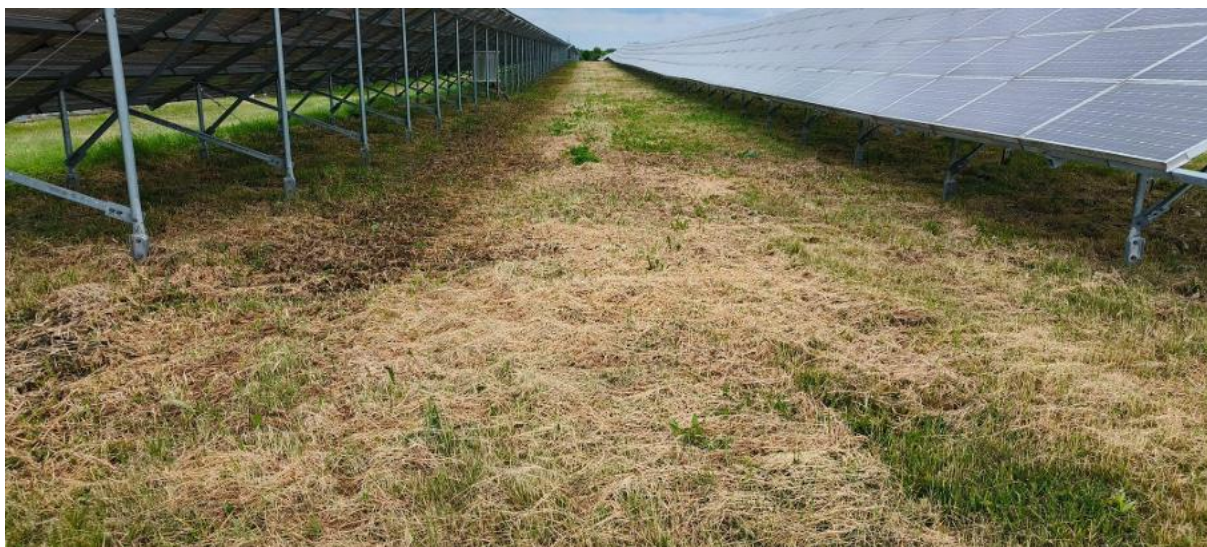
Obr.11. Biomasa po seči ponechána na ploše FVE Tasov; 20.v. 2025. Foto: Zdenko Večerík
