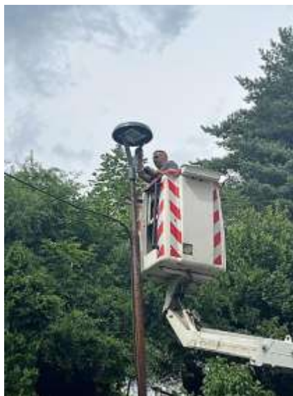
Montáž nového dekoratívneho LED svietidla
