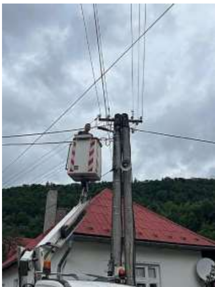
Demontáž pôvodných a montáž nových svietidiel
